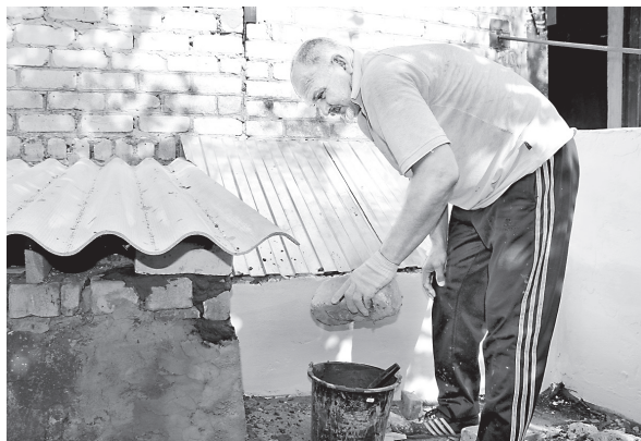
Текущий ремонт проводит И.Н. Петров.
